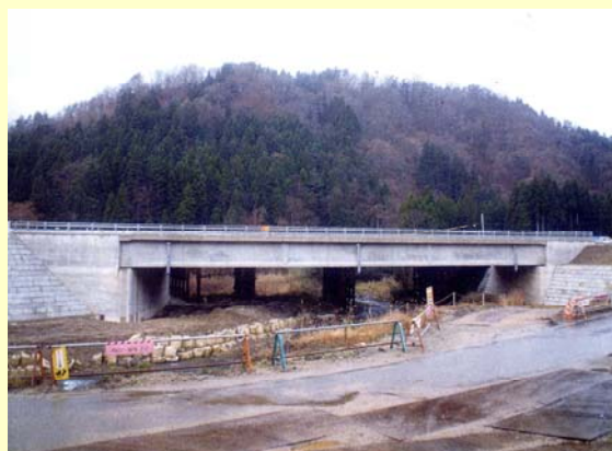
架替後の明月橋
