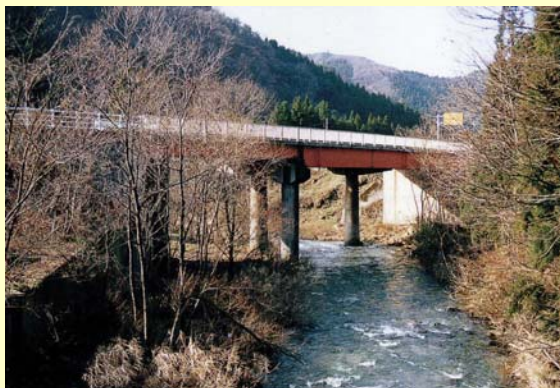
架替前の明月橋
